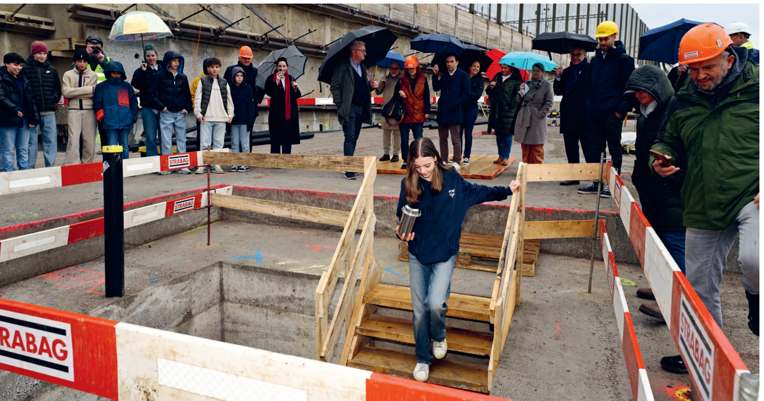
Am 25. März versenkte die Sekundarschule 1D Kilchberg-Rüschlikon in einem feierlichen Akt eine Zeitkapsel in einer Vertiefung des Betonfundaments und legte damit symbolisch den Grundstein für die Überbauung «Bahnhof Süd» (Bild: BILDOGRAPHIE® SWISS / danièle lupini).
