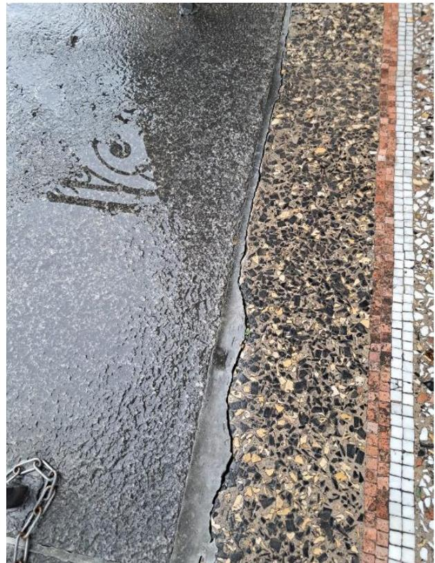
Um das Schadensbild besser beurteilen zu können, wurden umgehend Sondierungen in der Deckenkonstruktion unterhalb der Terrasse beauftragt und durchgeführt; dabei wurden starke Korrosionsschäden bei den Stahlträgern in der Hourdisdecke, grosse Kiesnester (keine gute Verbundwirkung) im Betondruckbogen-Bereich sowie defekte Abdichtungen festgestellt.
